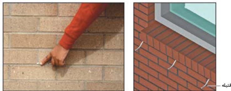
شکل ۵-۱۵- فتیله‌های از جنس طناب‌های پنبه‌ای جهت حفره‌های زه‌کشی
