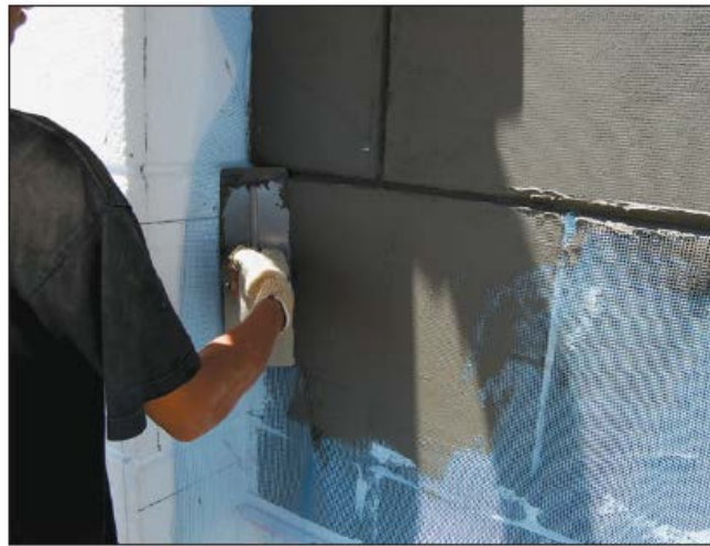
شکل ۱۱-۷- اجرای لایه‌های پوششی
