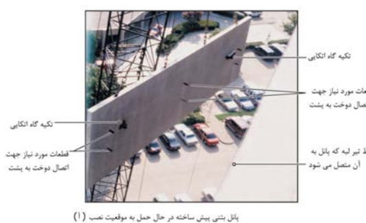
شکل ۱۰-۷- نمونه‌ای از اتصال دوخت به پشت
