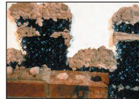
الف- وسیله مهار ملات همراه تکه‌های ملات به گونه‌ای که اجازه می‌دهد آب از آن عبور نموده و روانه حفره‌های زهکشی شود.
