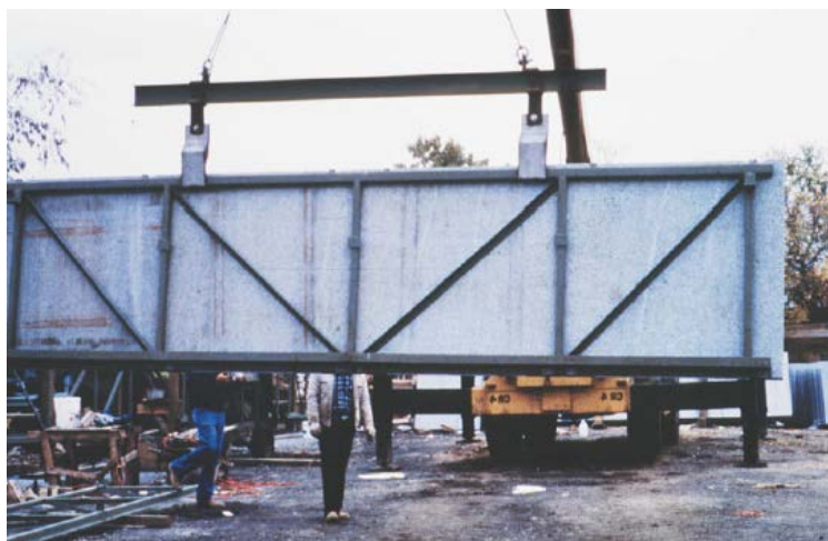
شکل ۴-۲۱- پانل دیواری پرده‌ای پیش ساخته سنگی
