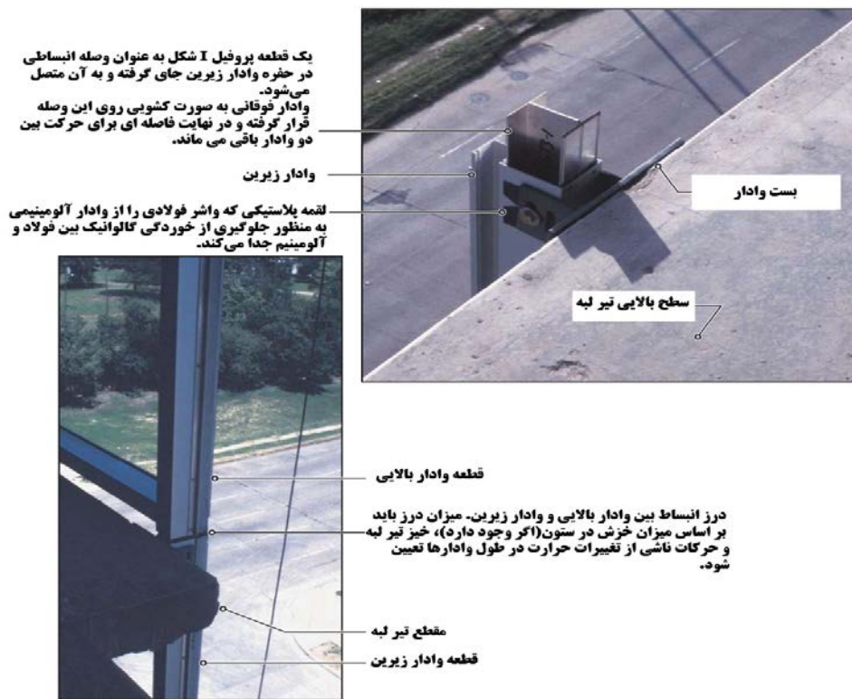
شکل ۹-۷- نمونه اتصال انبساطی بین دو قطعه وادار
