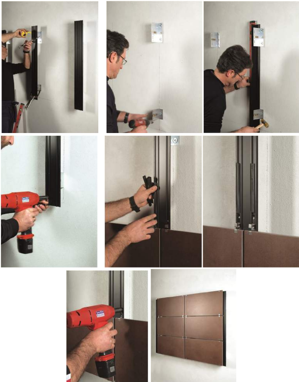
شکل ۷-۲۴- مراحل نصب سیستم نصب نمایان
