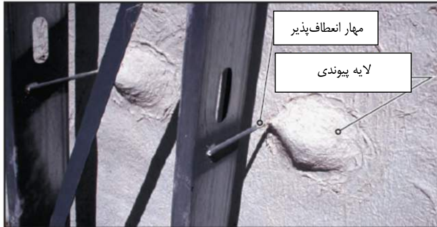
شکل ۶-۳۸ - لایه پیوندی و مهارهای انعطاف‌پذیر
