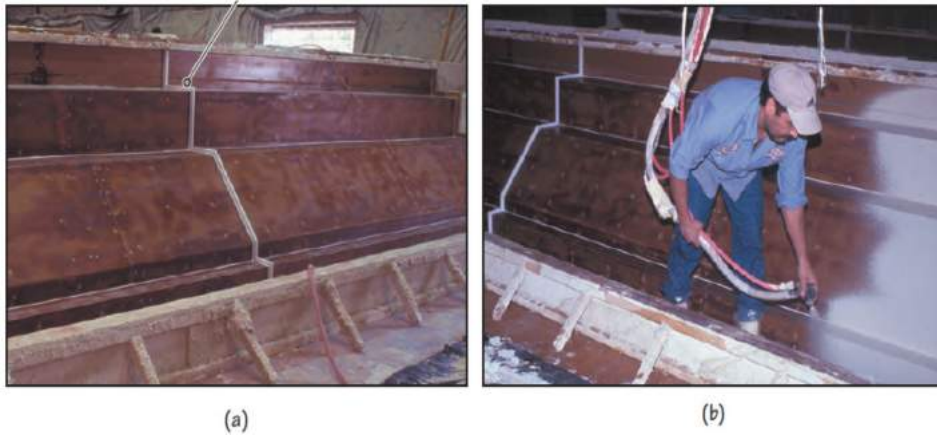
شکل ۶-۴۰-الف) قالب پانل GFRC (ب) پاشیدن لایه آستر بر روی قالب
