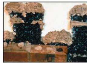
ب- وسیله مهار ملات همراه تکه‌های ملات به گونه‌ای که اجازه می‌دهد آب از آن عبور نموده و روانه حفره‌های زهکشی شود.
