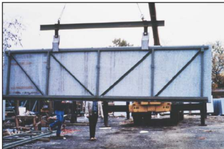
شکل ۴-۲۵- پانل دیواری پرده‌ای پیش‌ساخته سنگی
