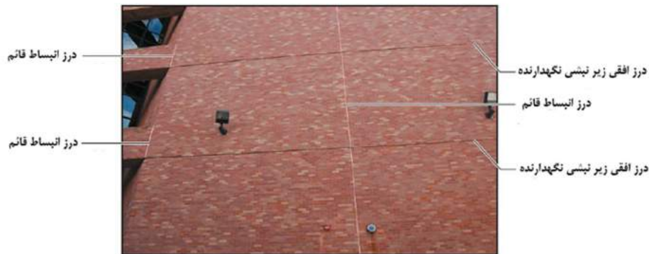
شکل ۵-۱۹- درز انبساطی پیوسته در نمای آجری
