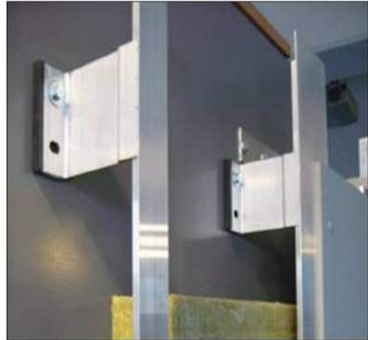
شکل ۶-۴۵- نمونه‌های زیرقاب ساخته‌شده با قطعات آلومینیومی
