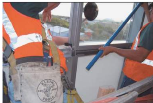
اعمال نیرو به قطعه جدید جهت نصب به اتصالات
