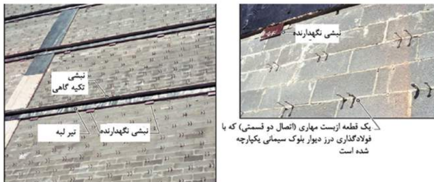
الف - نشی های نگهدارنده به زیر تیر لبه اتصال می یابد. فواصل این نشی ها تابع بار جانبی اعمال شده به دیوار است.
