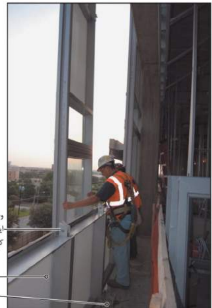
وصله ها در قطعه زیرین. این وصله ها جهت توسعه نما و نیز جابجایی آنها کاربرد دارند. قطعاتی که نصب شده اند بست های بار ثقلی
