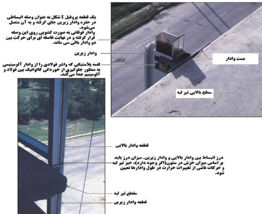
شکل ۸-۸- نمونه اتصال انبساطی بین دو قطعه وادار
