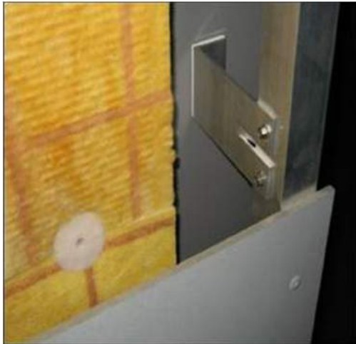
شکل ۶-۴۵- نمونه‌های زیرقاب ساخته‌شده با قطعات آلومینیومی
