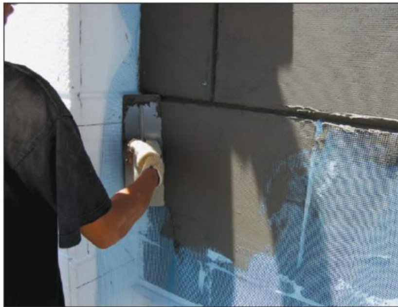
شکل ۶-۱۸- اجرای لایه‌های پوششی
